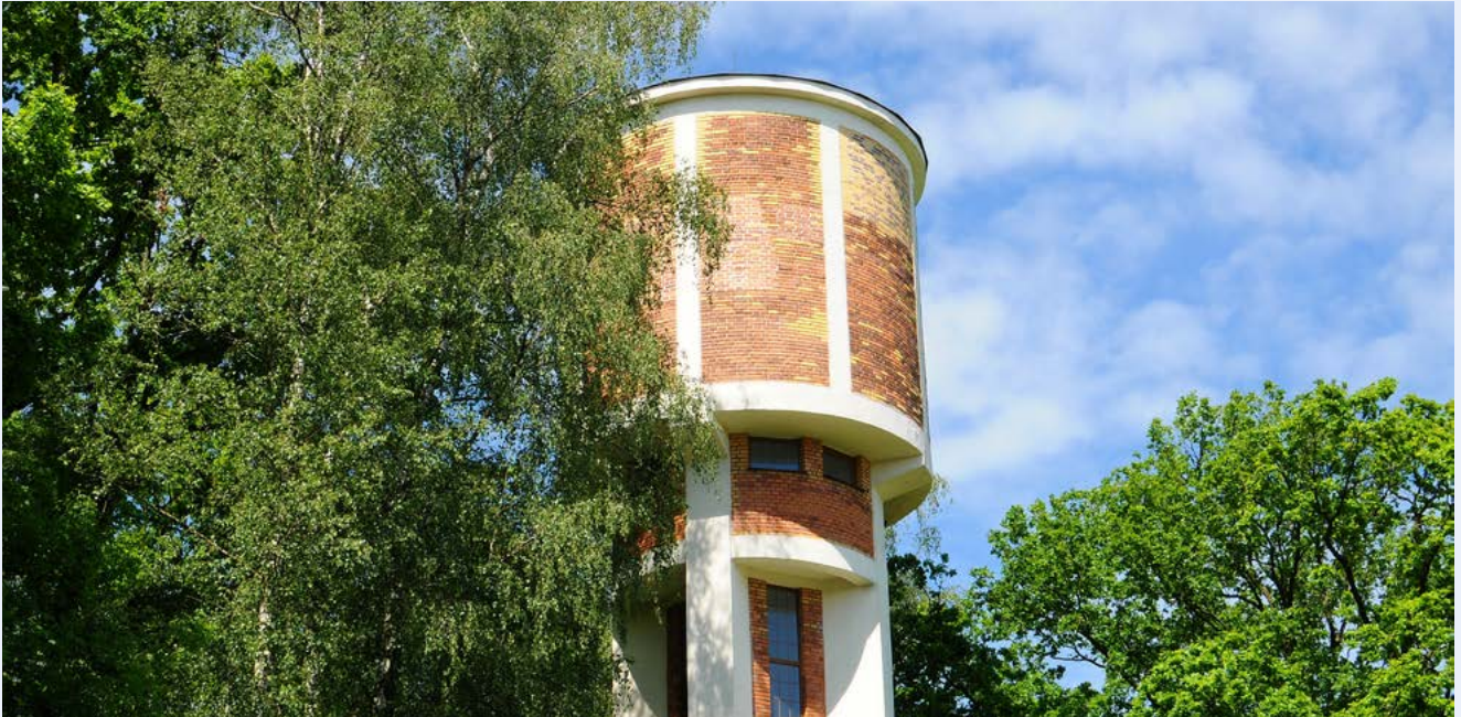
Věžový vodojem v obci Lučina na břehu Žermanické přehrady mezi Frýdkem-Místkem a Havířovem.
