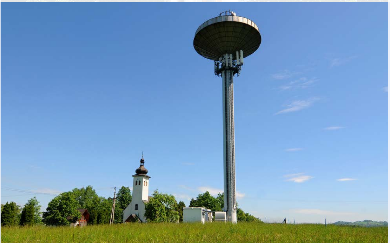
Věžový vodojem s vedlejším kostelem Navštívení Panny Marie nad obcí Soběšovice nad Žermanickou přehradou vybudovanou na řece Lučině. Má kapacitu 250 metrů krychlových pitné vody.
