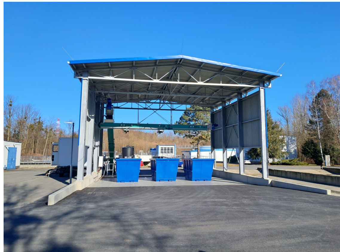
ČOV Frenštát pod Radhoštěm - rekonstrukce kalové koncovky: 18 mil. Kč
