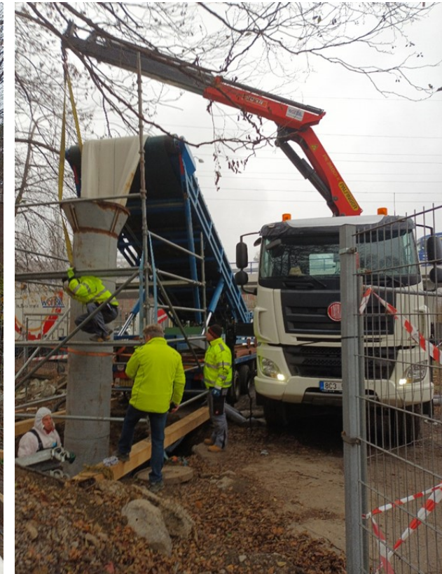
Instalace inverzního rukávce (kanalizace)
