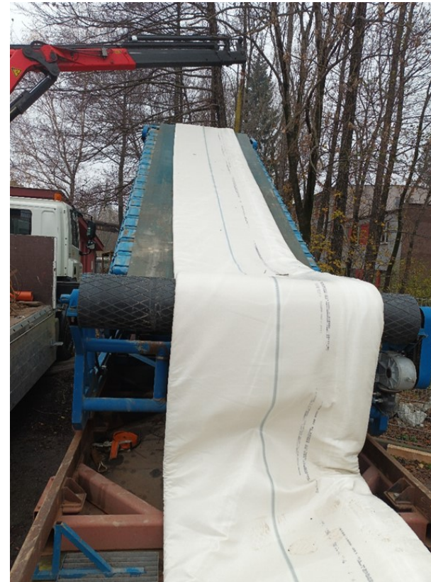
Instalace inverzního rukávce (kanalizace)
