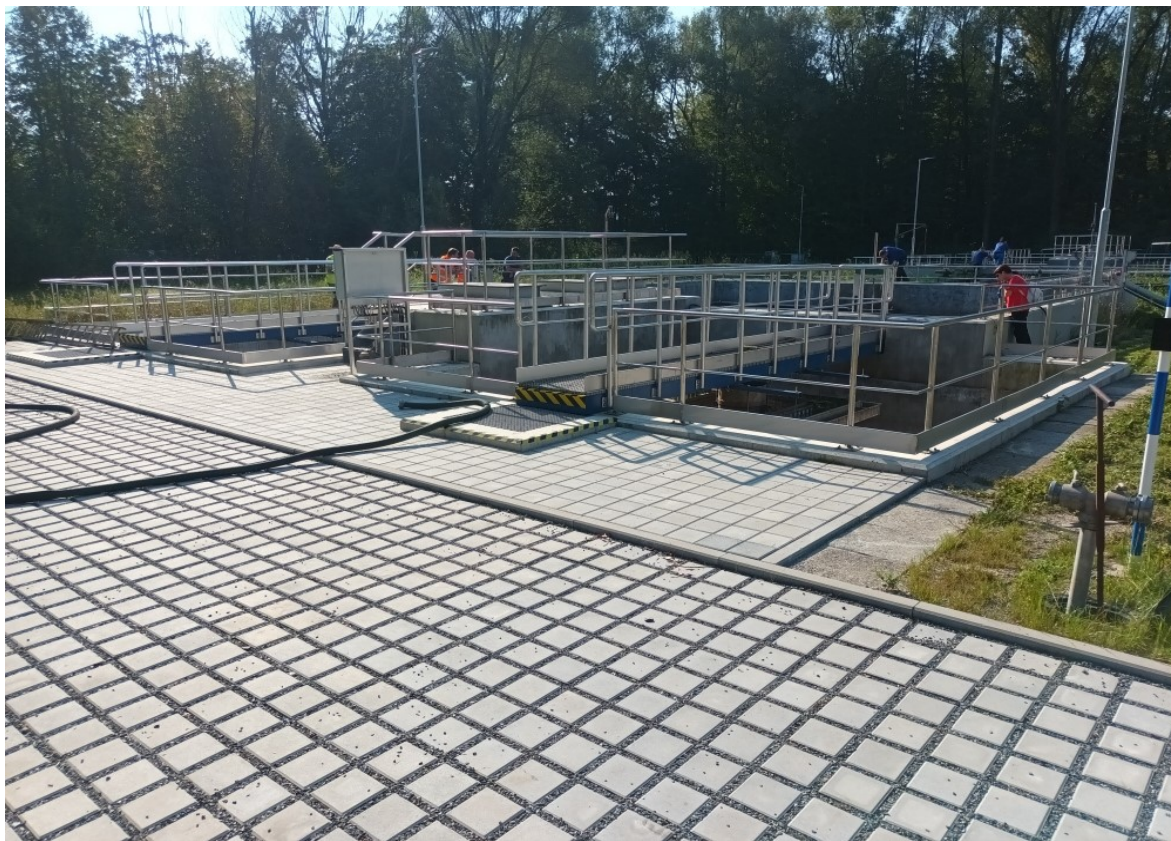
ČOV Albrechtice - rekonstrukce a oprava technologické a stavební části: 34 mil. Kč
