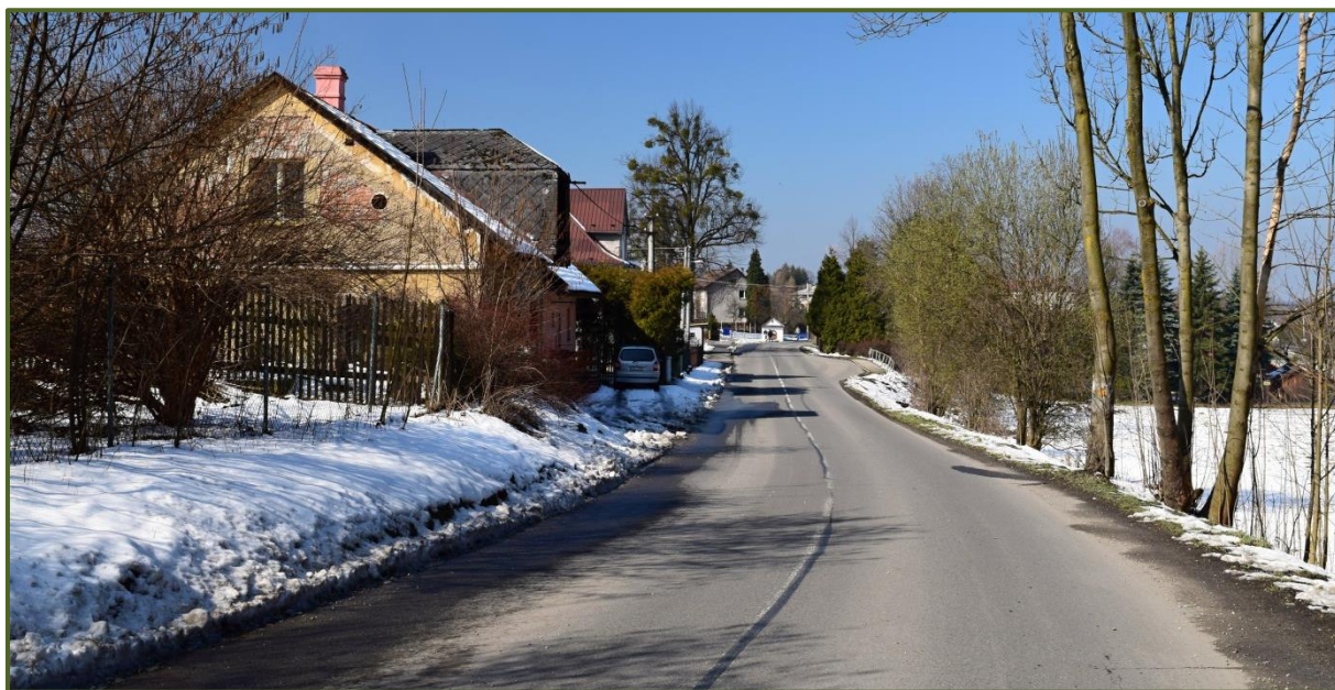
Obrázek č. 19: Silnice č. III/4774
